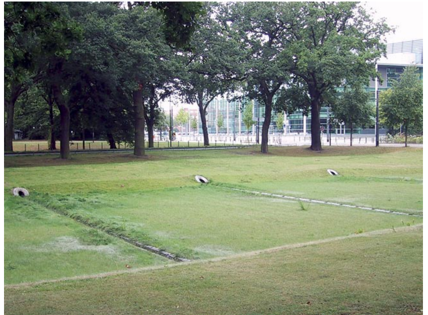
Bodenfilter an der Holler Allee
